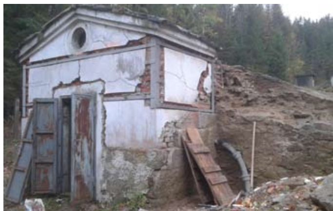
Prameniště Starý Ždánov - objekt SO 02 vodojem před rekonstrukcí
