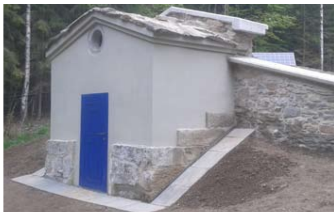
Prameniště Starý Ždánov - objekt SO 02 vodojem po rekonstrukci
