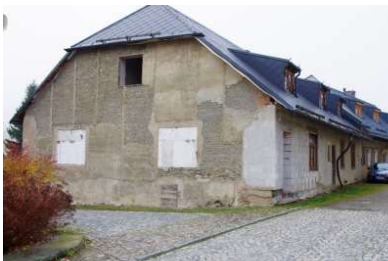
Probíhající rekonstrukce budovy na náměstí č.p. 149 (2021)
