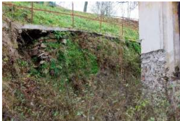
Opěrné zdi v havarijním stavu
