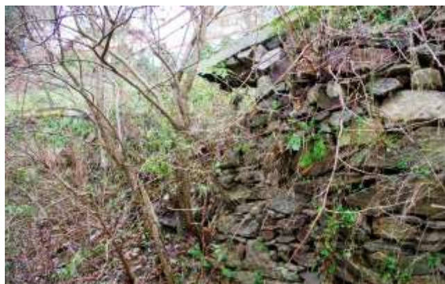
Opěrné zdi v havarijním stavu
