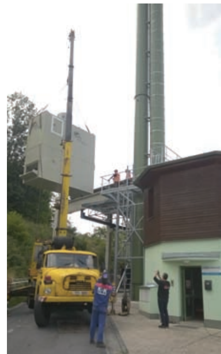
Instalace mokré vypírky
