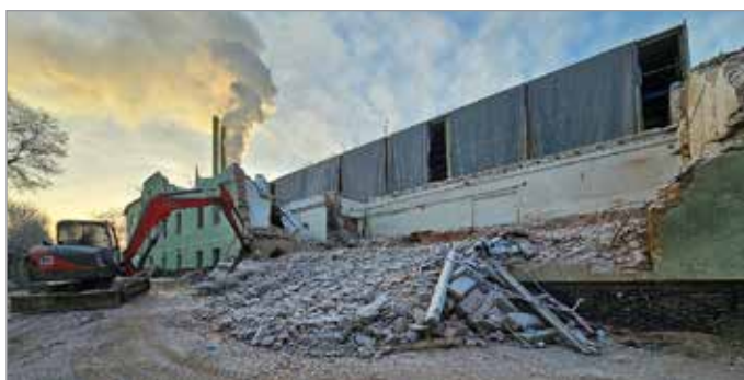
Demolice administrativní budovy pily – leden 2025
