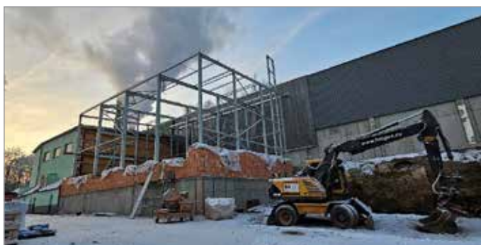
Výstavba ocelové haly – prosinec 2025
