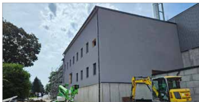
Nová hala – červenec 2026
