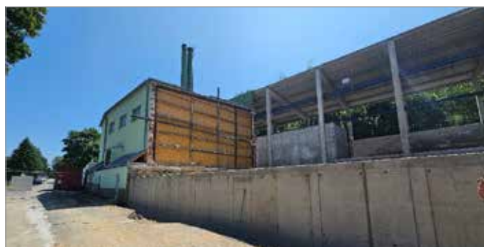
Založení nové haly – červen 2025
