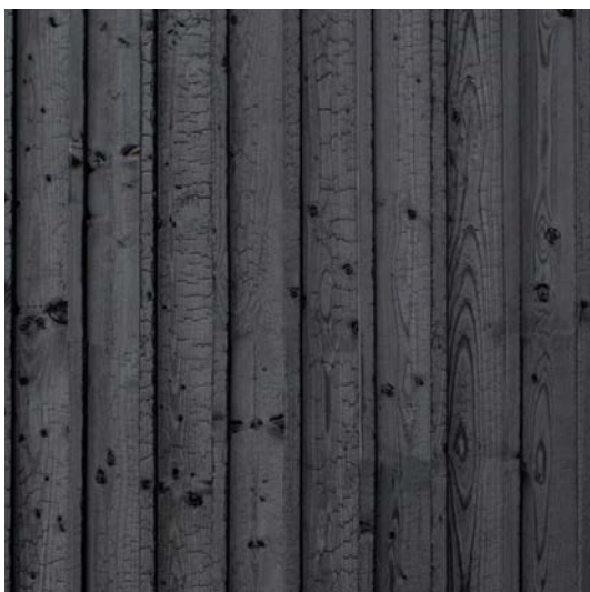
fasádní dřevěné latě opálené
