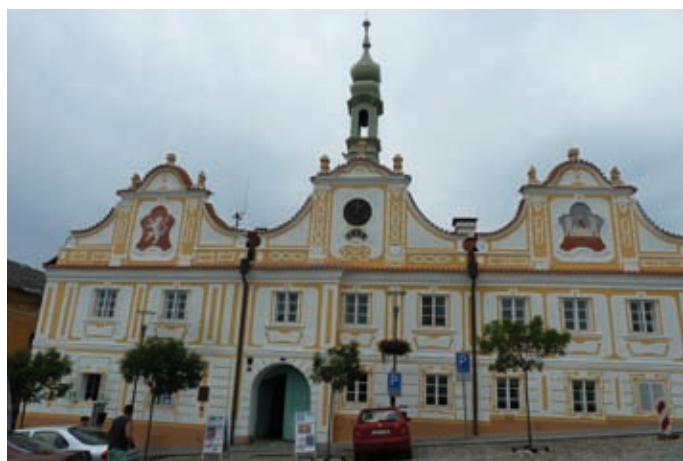
Východní průčelí radnice v Kašperských Horách po obnově v r. 2016
