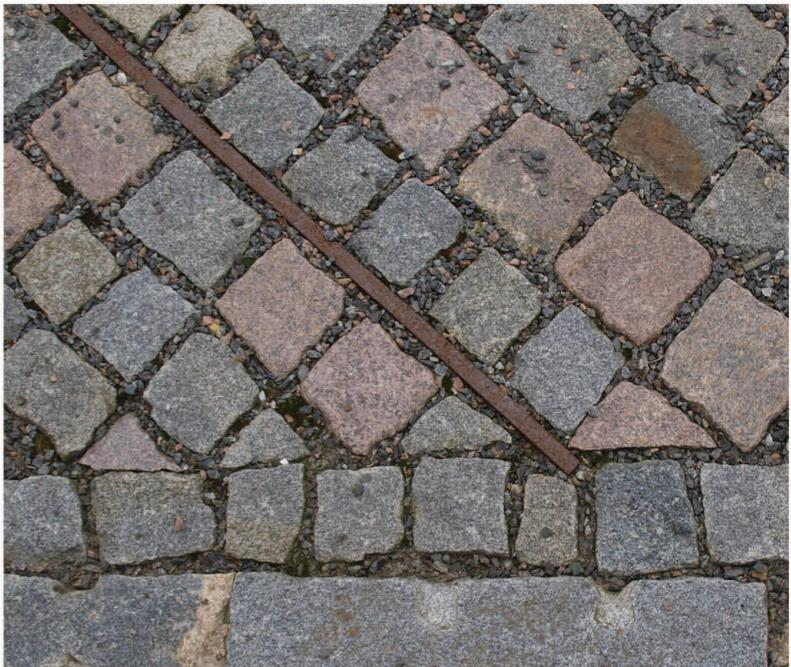
členění parkovacích stání elegantním ocelovým pásovým profilem v úrovni dlažby realizované v historickém centru Litomyšle
