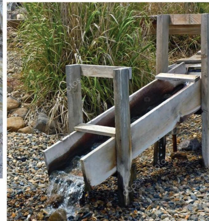
část vodního toku potoka může být odkloněna do prostoru pobytové louky dřevěným korytem z tvrdého masivního dřeva
