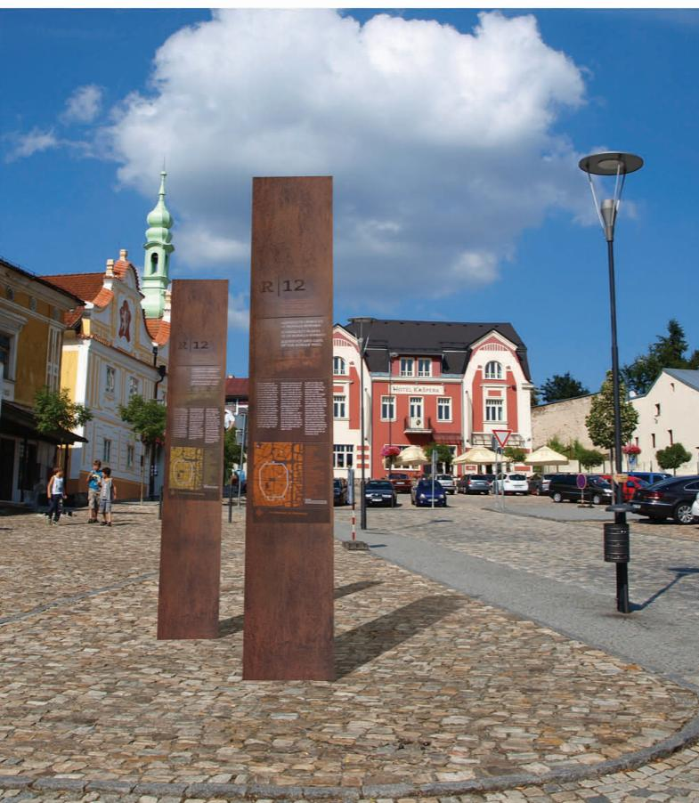
příklad vhodného řešení informačního systému nejen v historické části obce \_ ocelový plát tl. cca 10 mm kotvený pod úrovní dlažby s jednotnou grafickou úpravou (kombinace potisku případně fólie s laserovým vyřezáváním)
