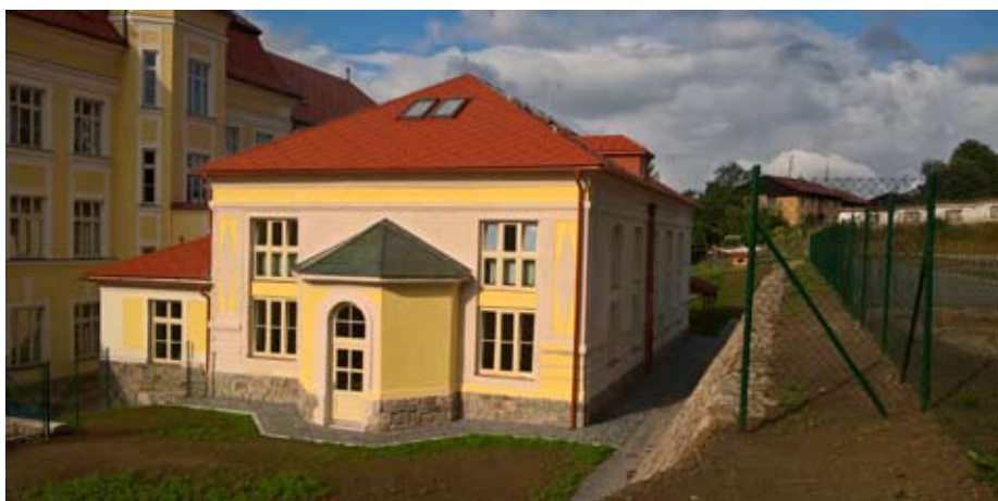
Bývalá tělocvična po rekonstrukci (foto: Jana Slonková)
