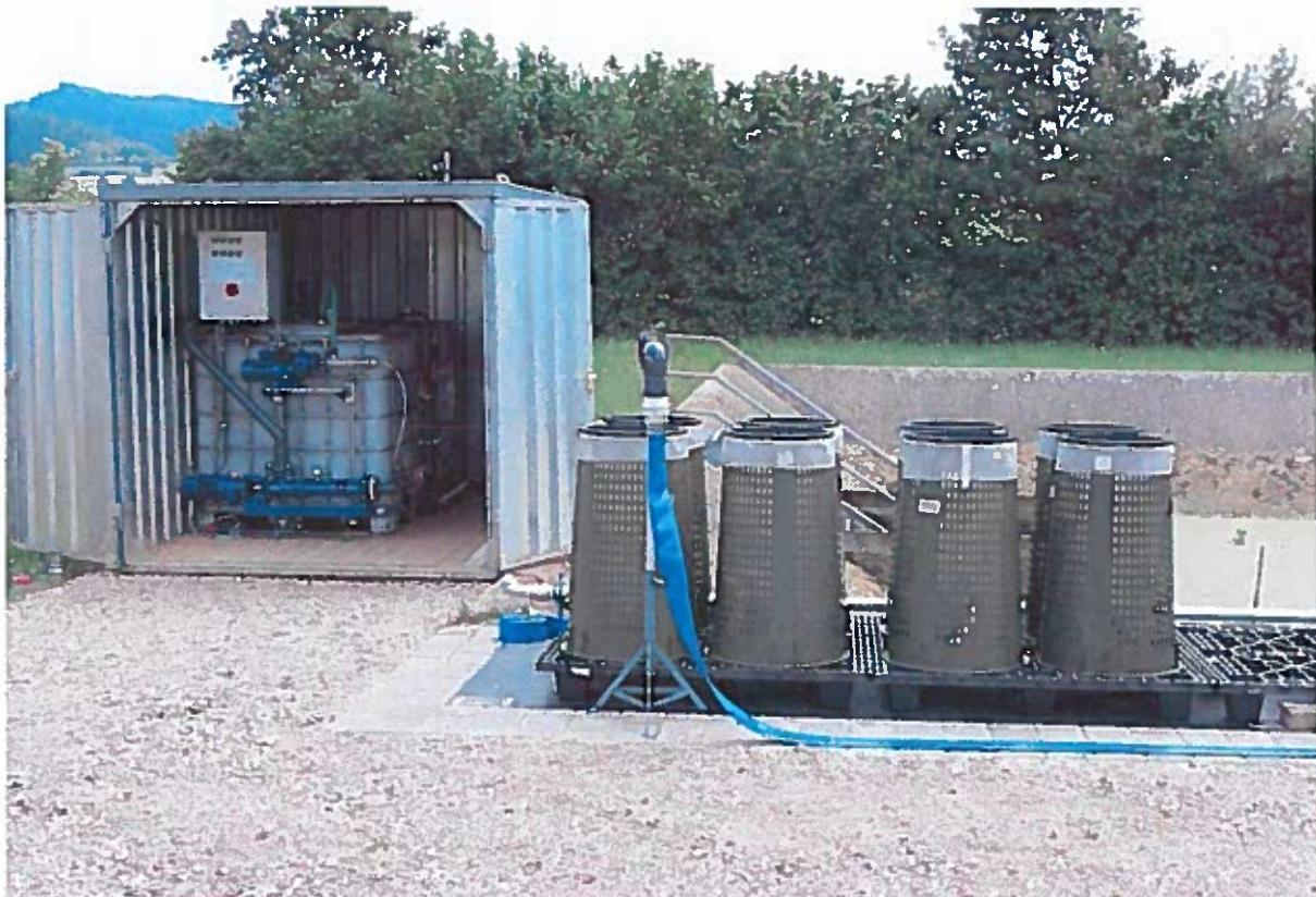
**Odvodňování kalu dávkovač, míchací stroj, filtrační a odvodňovací pytel**
